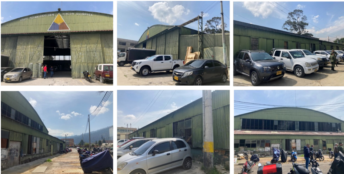
Registro fotográfico de las áreas exteriores del hangar
