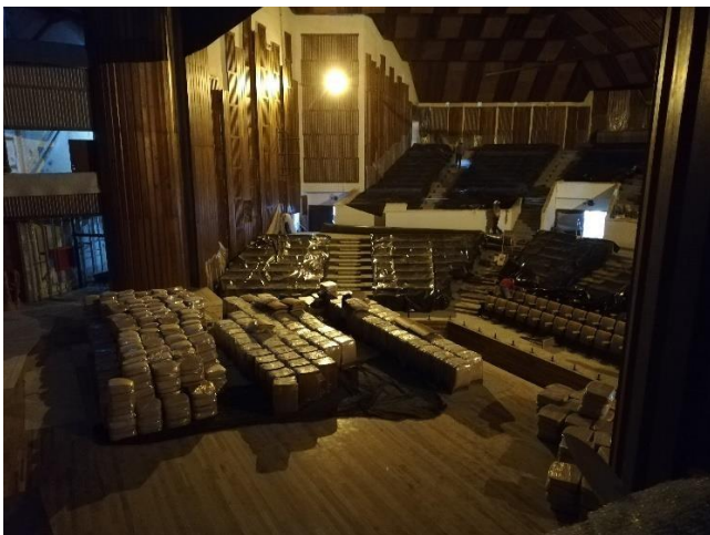
Fuente: Visita León de Greiff, julio 29 de 2022. Vista auditorio principal, instalación silletería.
